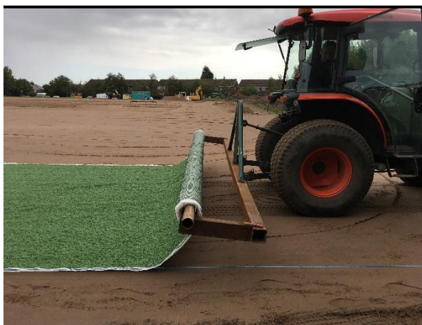
Figura 2. Installazione del tappeto ibrido a Thatto.
