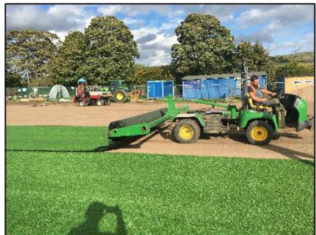
Figura 3. Installazione del tappeto ibrido a Siddal.
