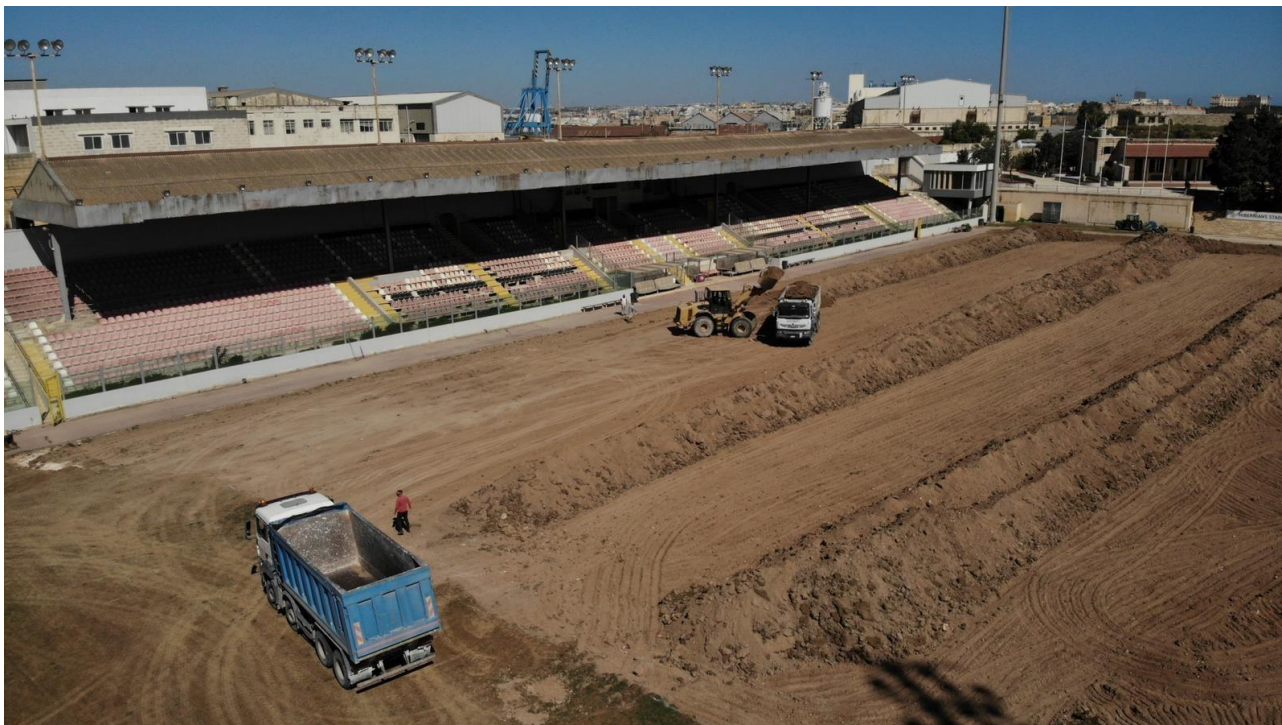
Figura 3: caricamento del terreno rimosso su camion l'8 maggio
