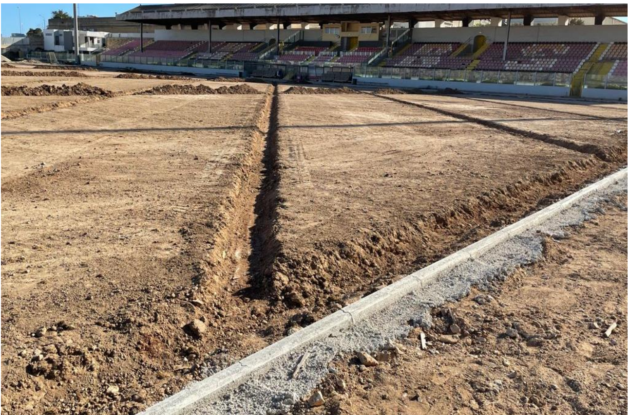
Figura 8: l'installazione dei cordoli e le trincee per i tubi il 22 maggio th
