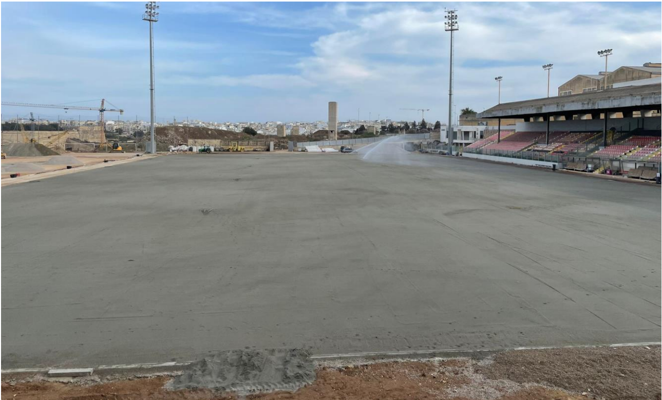
Figura 15: completamento della posa dello strato di sabbia il 31 maggio
