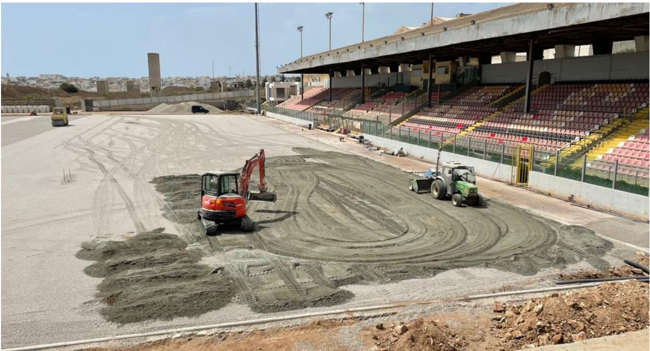
Figura 14: inizio della posa dello strato di sabbia il 29 maggio
