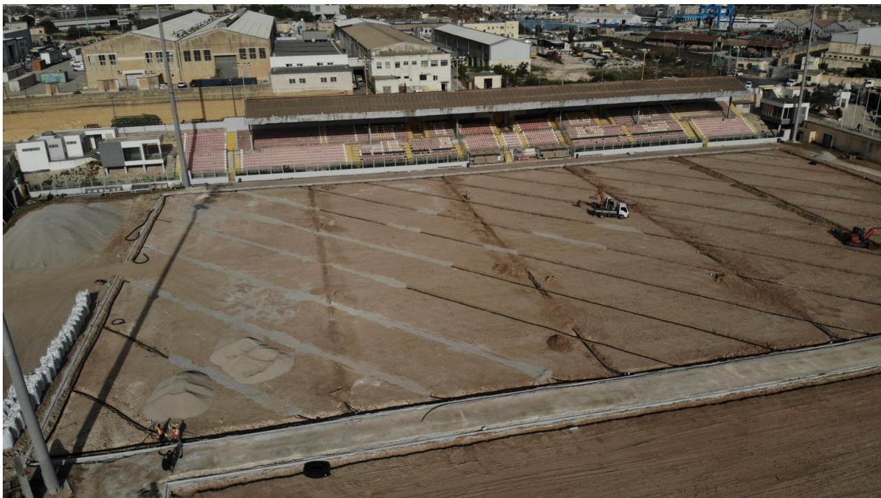
Figura 9: installazione dei tubi e riempimento delle trincee il 24 maggio. th
