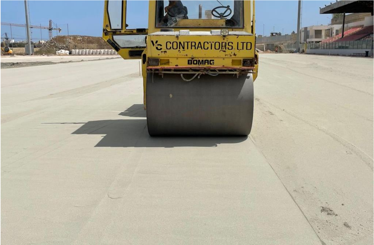
Figura 13: rullatura dello strato di pietrisco il 29 maggio
