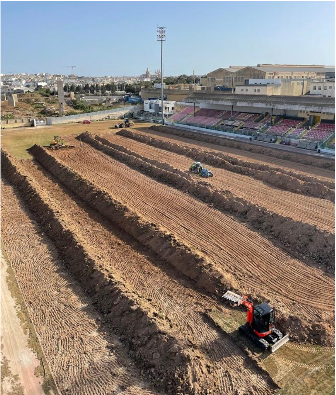
Figura 2: scoticamento e livellamento il 7 maggio
